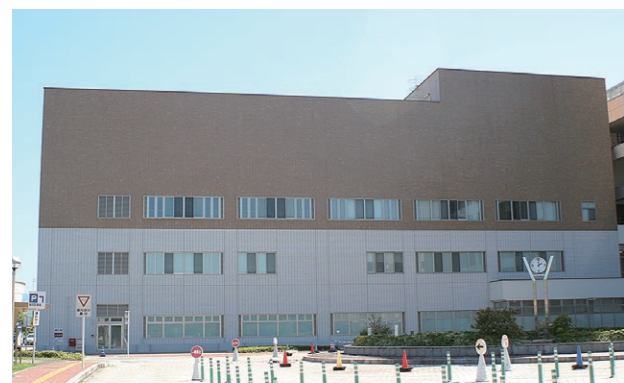
附属病院(東棟)外観
